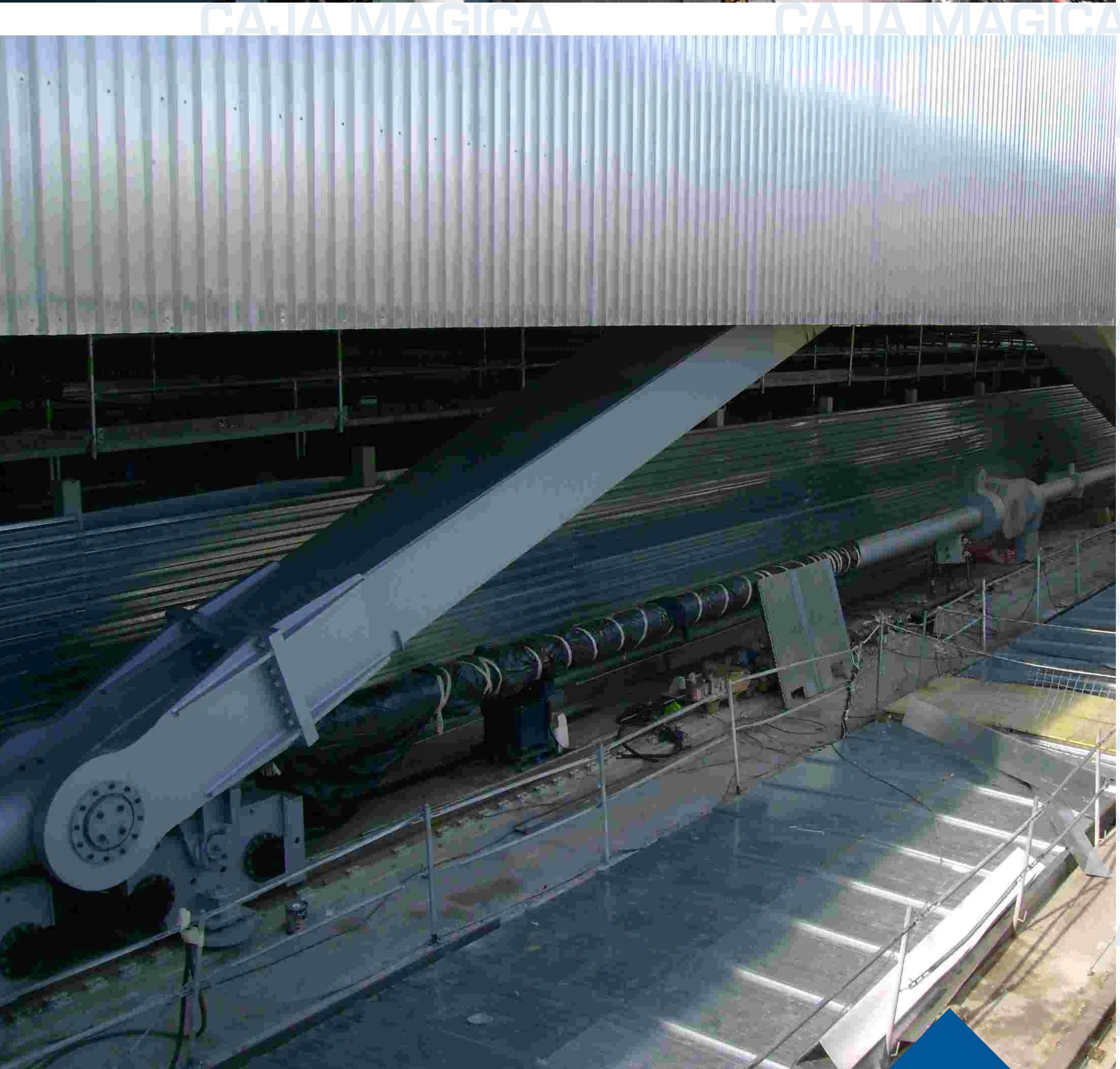
Conjunto de mecanismos de cubierta móvil 1. Cierre finalizado y elementos mecánicos conectados.
